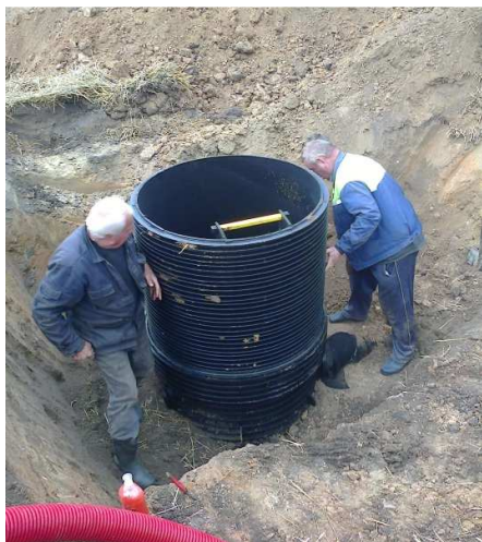
3.1.1.17 pav. Drenažo nuotėkio reguliavimo šulinių statyba Kėdainių r. instituto lauko bandymų skyriaus žemėje (kairėje), įrengtas šulinys (dešinėje)
