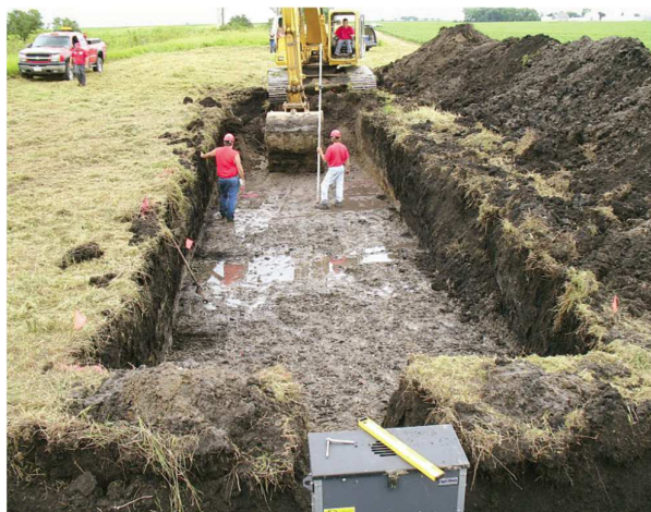
3.1.1.9 pav. Denitrifikuojančio bioreaktoriaus įrengimas Ajovos valstijoje, JAV (Christianson and Helmers, 2011)
