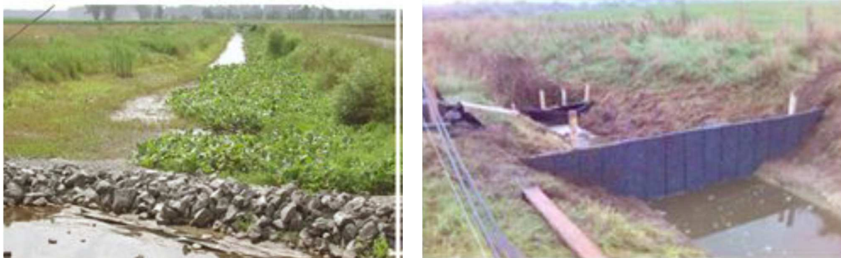
3.1.1.4 pav. Suformuotas sedimentacijos tvenkinėlis praplečiant griovio skerspjūvį (kairėje) pertvarkta griovio vaga (dešinėje) (Avery, 2012)
