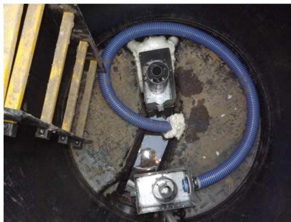
3.1.1.18 pav. Drenažo vamzdis vandens ištekėjimo lygiui reguliuoti (kairėje), įranga drenažo nuotėkiui matuoti šulinio viduje (dešinėje)
