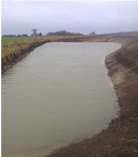
3.1.1.13 pav. Praplatus ir pagilinus griovio vagą įrengta gilioji šlapynės dalis - nešmenų nusėdintuvas (kairėje), pritekančio vandens monitoringo postas (dešinėje)
