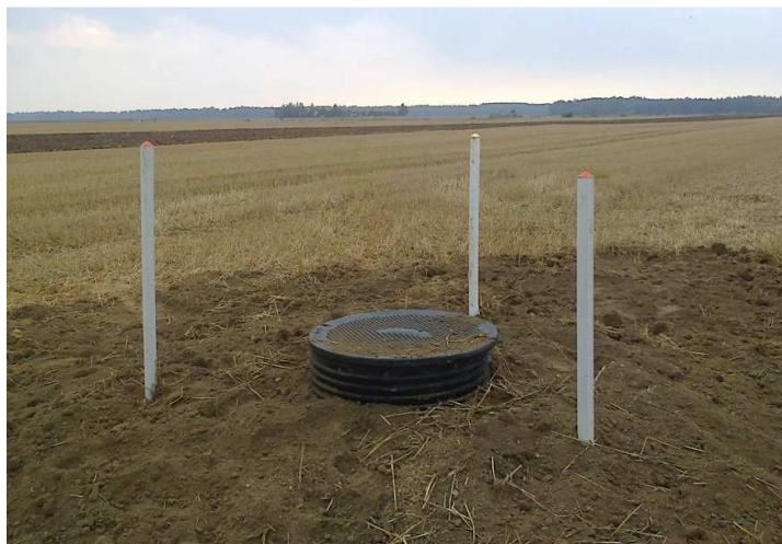
3.1.1.17 pav. Drenažo nuotėkio reguliavimo šulinių statyba Kėdainių r. instituto lauko bandymų skyriaus žemėje (kairėje), įrengtas šulinys (dešinėje)
