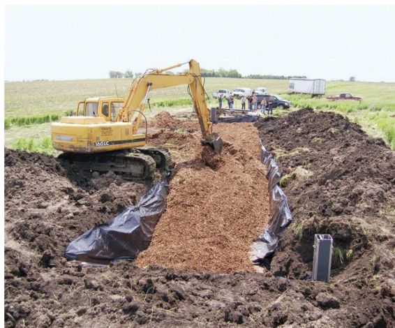
3.1.1.9 pav. Denitrifikuojančio bioreaktoriaus įrengimas Ajovos valstijoje, JAV (Christianson and Helmers, 2011)
