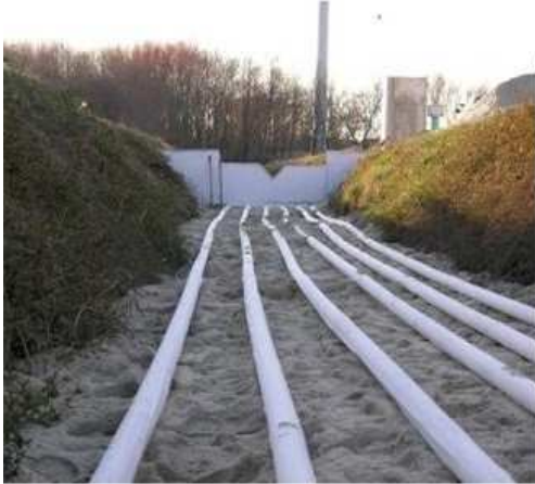
3.1.1.10 pav. Ištirpusio fosforo pašalinimo technologija melioracijos grioviuose, kurių vanduo stipriai užterštas fosforo junginiais (Bryant et al., 2012)
